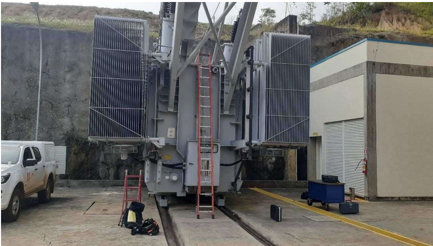
Figura 10 - Detalhe vista lateral
