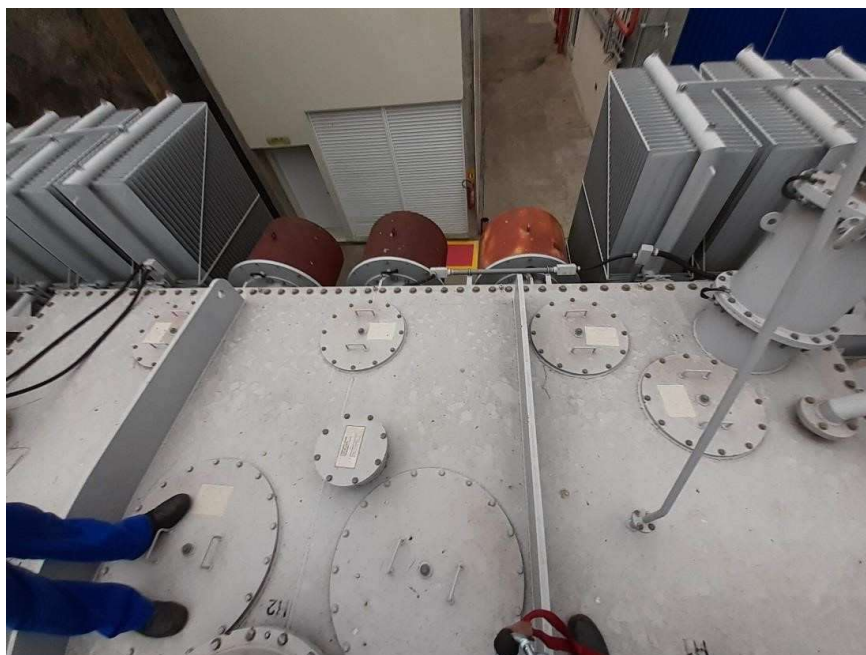
Figura 11 - Detalhe das janelas de inspeção na tampa superior
